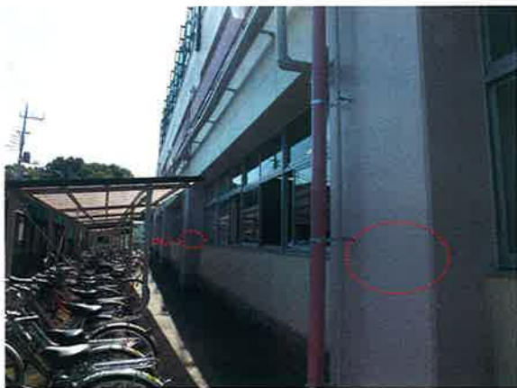
↑スパック工法は柱を太く、美観を損ねない工法
